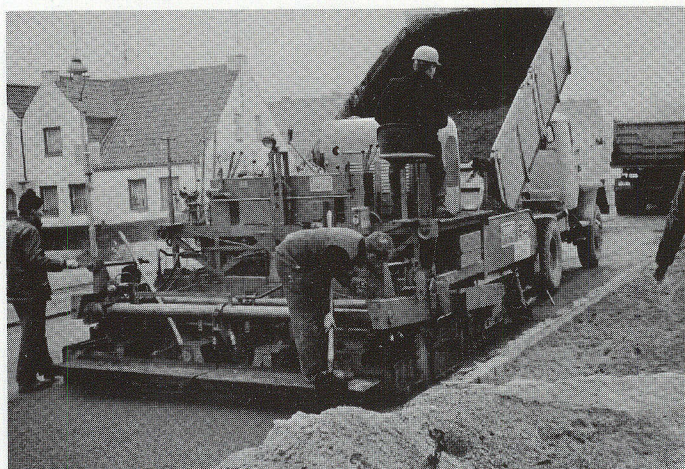
Der Ausbau der Ziegelstraße geht voran!
